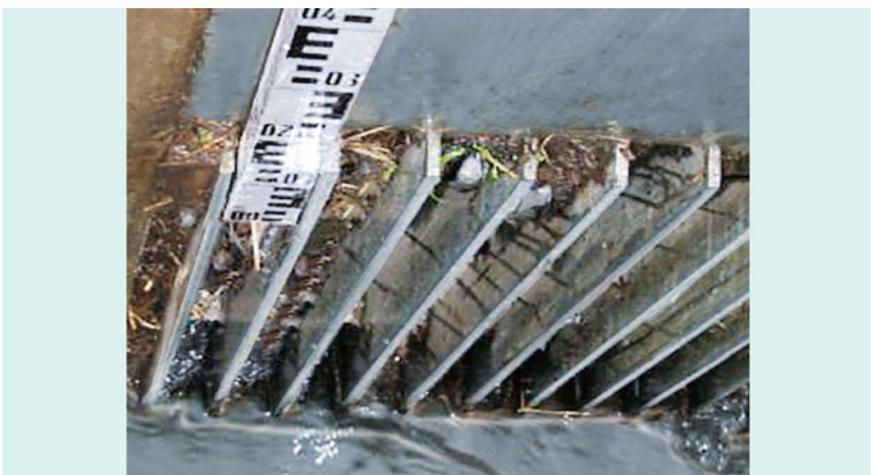
**Fig. 4.12** Bar rack with 40 mm clear space in front a turbine intake (Ingenieurbüro Floecksmühle GmbH)
