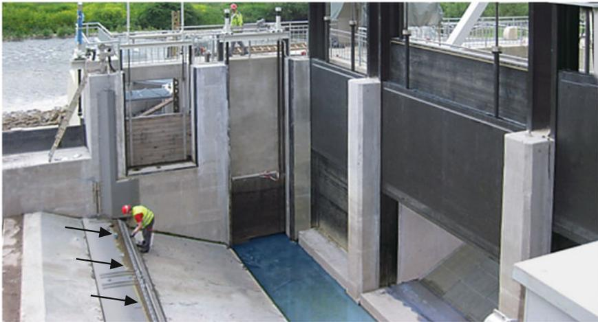
**Fig. 5.15** Bottom Gallery™ at the hydropower station Unkelmühle on the German river Sieg (Ingenieurbüro Floeckmühle GmbH)
